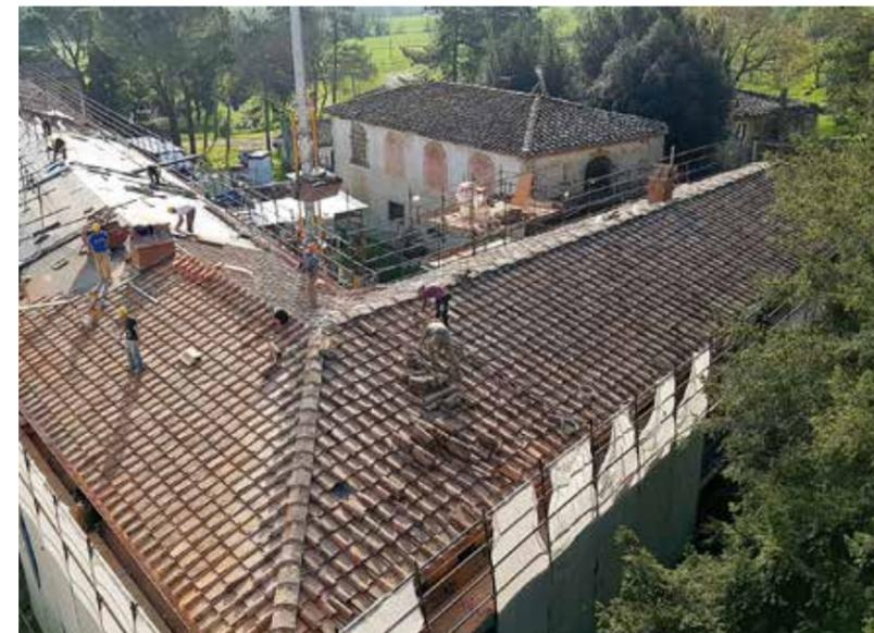
È stata **migliorata la resistenza statica** mediante la realizzazione di un cordolo metallico all'interno delle murature perimetrali ed è stata aumentata la capacità coibente inserendo dei pannelli termoisolanti sopra lo scempio.
